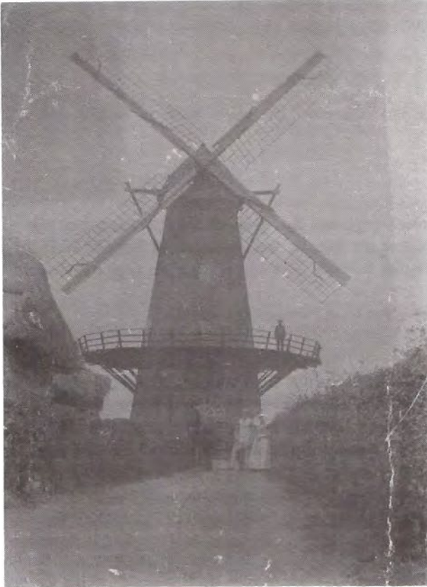
27. Molen "De Haas" te Oud-Sabbinge. In 1928 brandde de molen voor een deel af. Wieken werden er niet meer aangezet. De molen draaide tot 1987 op motorkracht. Foto: GA-Goes.
