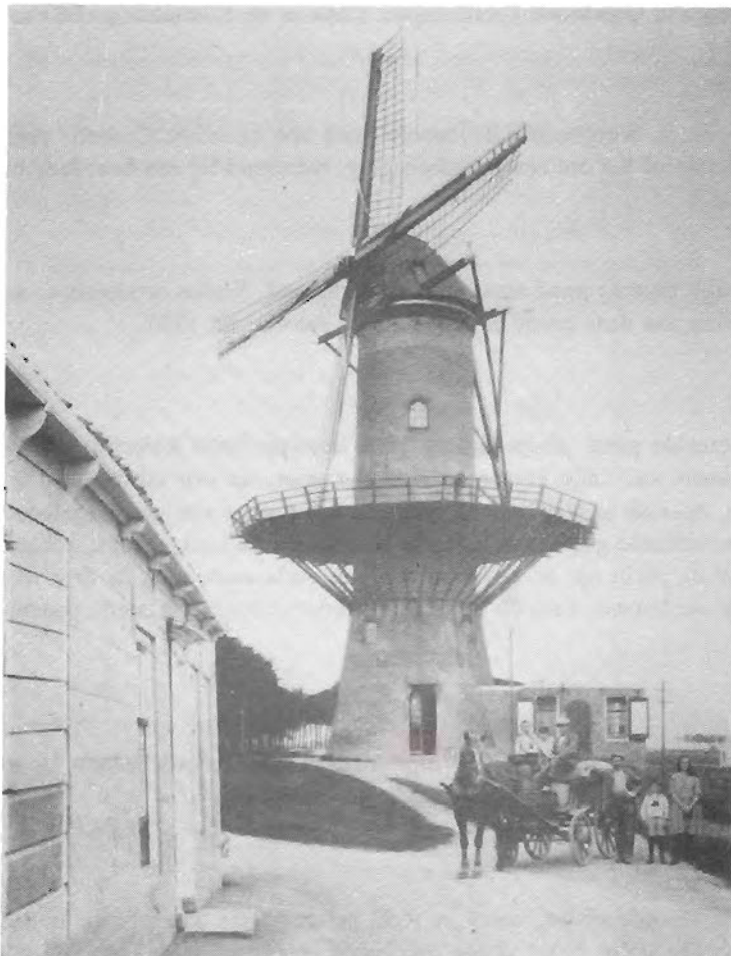
27. Molen "De Haas" te Oud-Sabbinge. In 1928 brandde de molen voor een deel af. Wieken werden er niet meer aangezet. De molen draaide tot 1987 op motorkracht. Foto: GA-Goes.
