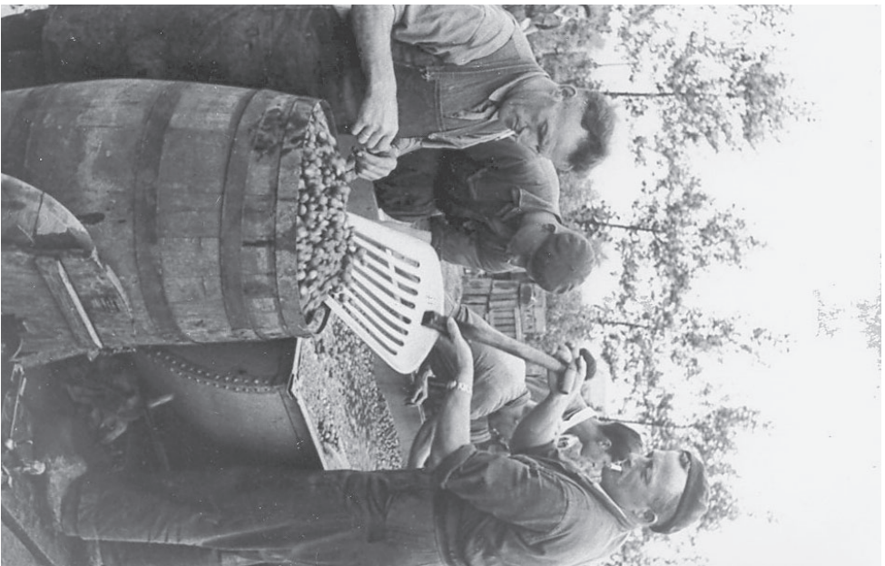
28. Vroeger werden de fabrieks-aardbeien al op het bedrijf of op de weiling verwerkt tot halffabricaat: de vruchten werden in een oplossing van sulfiet in tonnen gedaan. Deze tonnen werden opgeslagen bij de fabriek en in de inhoud werd in de loop van de winter verwerkt tot jam. Kapelle, circa 1930.
