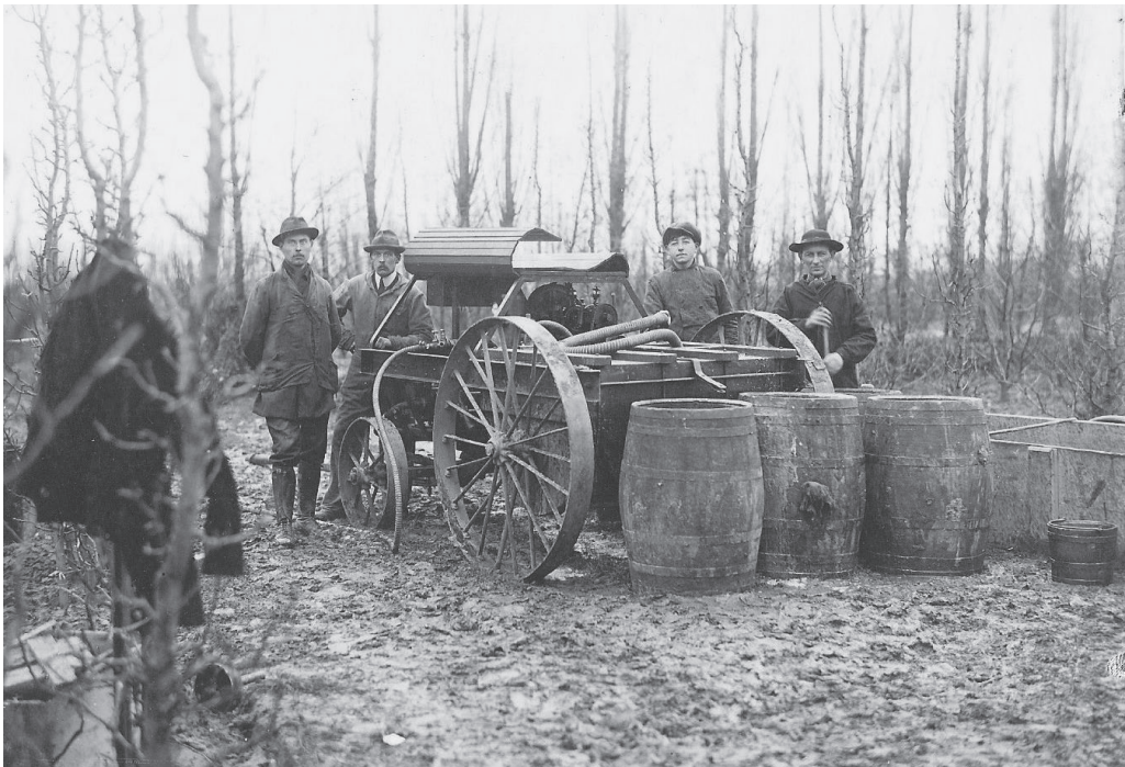
35. Motorspuit, hoeve 'Spoorzicht'.
