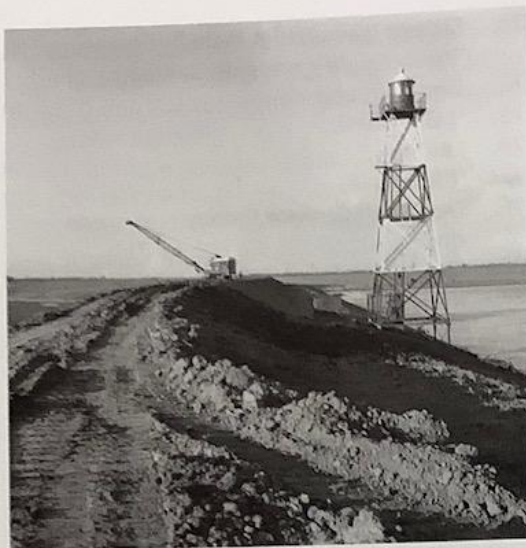
Afb. 4. Op deze foto van omstreeks 1965 het hoge licht met ook de werkzaamheden voor de versterking en verhoging van de zeedijk, foto C. Kotvis. (ZB Beeldbank Zeeland, recordnummer 106193.)
