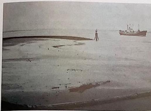
Afb. 3. Oeverafschuiving van 2 november 1960 ten zuiden van de Ruigendijk bij Hoedekenskerke in de zogenaamde 'Kleine Ham'. (Uit: M.H. Wilderom, Tussen Afsluitdammen en Deltadijken, deel III Midden- Zeeland, Middelburg 1968.)
